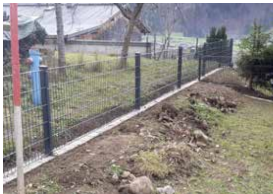
Neu errichteter Zaun
